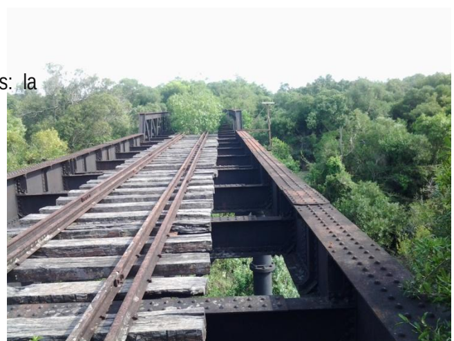
Figura 5. Puente de la antigua línea férrea sobre el Arroyo Cuaró Chico. Fuente: Registro fotográfico UNOT.
