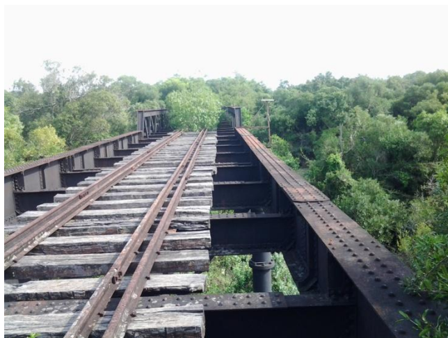
Figura 15. Puente de la antigua línea férrea sobre el Arroyo Cuaró Chico. Fuente: Registro fotográfico UNOT.
